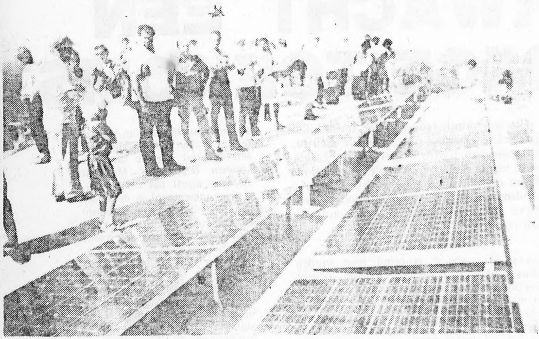
WILLEMSTAD - Belangstellenden bekijken de 128 zonnepanelen van de nieuwe zender van Radio Hoyer, het eerste commerciële FM station dat volledig op zonne-energie werkt.
